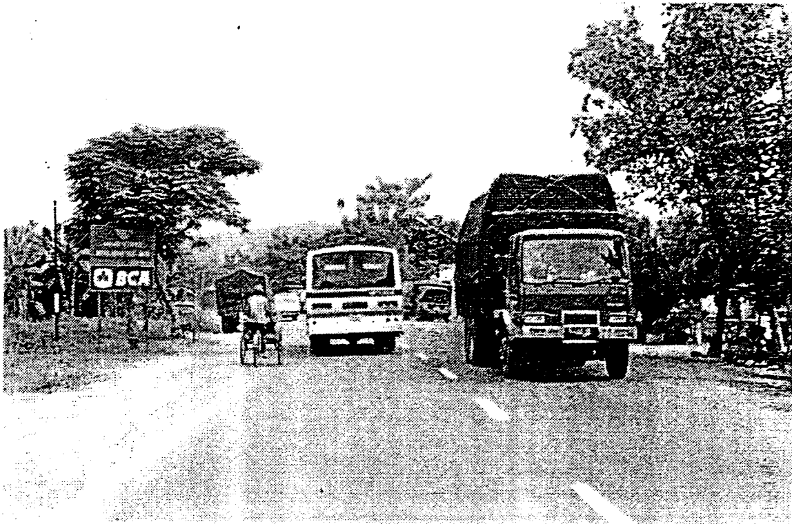
Penampang jalan dua-lajur dua arah tak terbagi dengan bahu kerikil yang lebar
