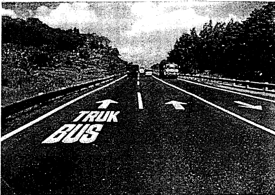
Jalan bebas hambatan tak-terbagi dengan tambahan lajur pendakian untuk kendaraan lebih lambat.
