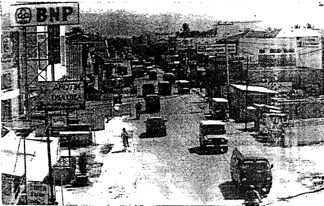
Jalan perkotaan dua-lajur dua-arah dengan bahu dan kondisi hambatan samping sedang
