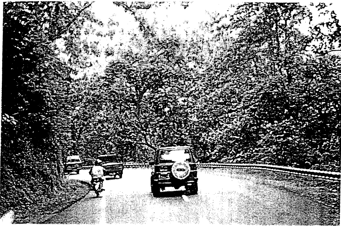
Penampang jalan dua-lajur dua arah tak terbagi pada alinyemen gunung
