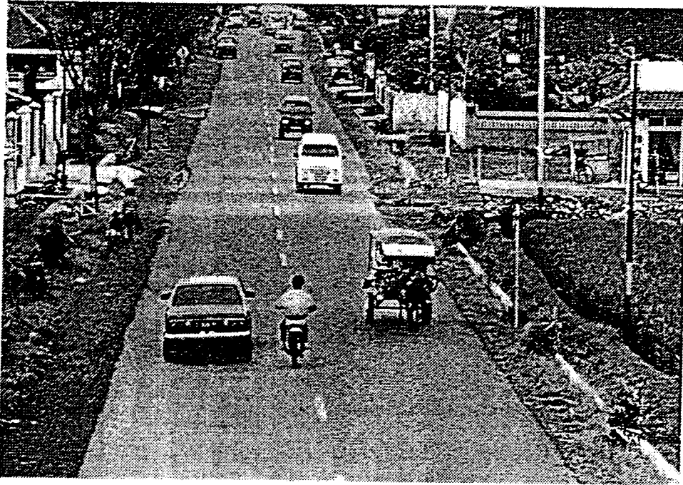
Gambar A-4:3 Hambatan samping sedang pada jalan luar kota
